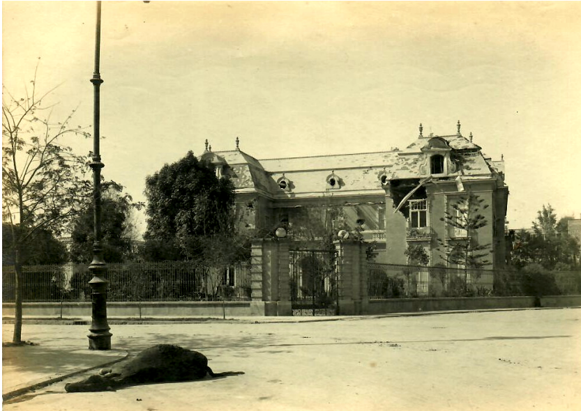
Foto 6. Casa de la familia Scherer, dañada por los bombazos de la Decena Trágica, febrero de 1913. AAM.
