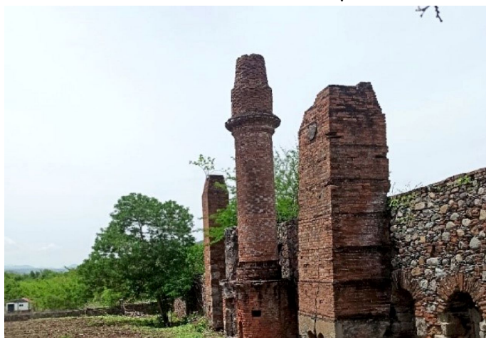
Imagen 8 Muro exterior de la casa de calderas y chimeneas.
