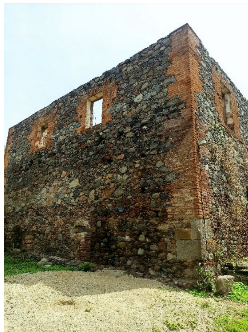
Imagen 5 Fachada sureste del purgar.
